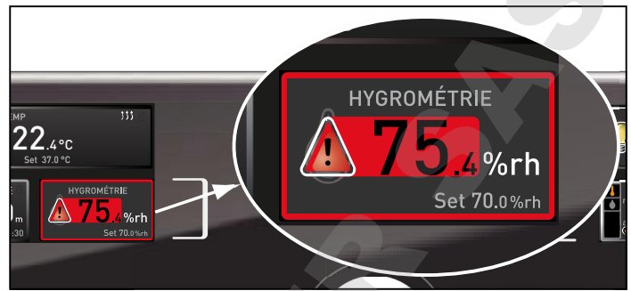
Ill. 21 Déclenchement du dispositif de sécurité hygrométrique
