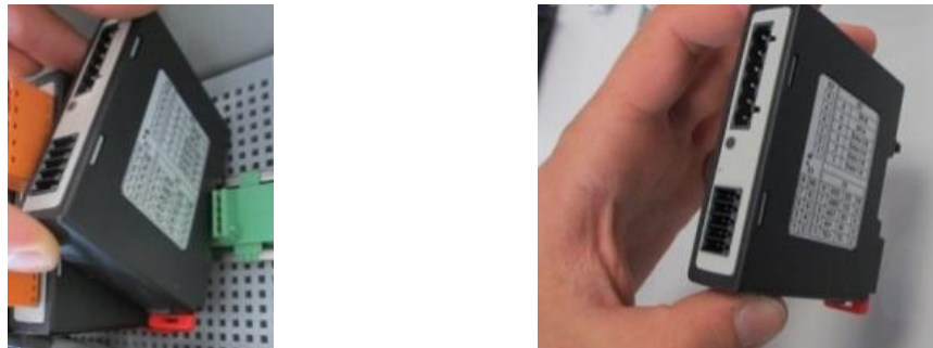
Fig. 10: Démontage des modules de régulateur - 2 e partie (figure similaire)
