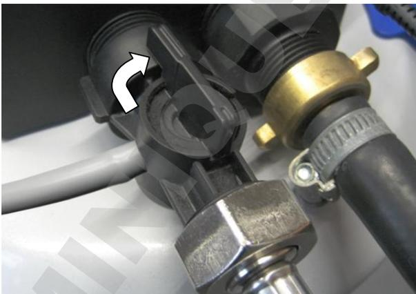
Fig. 10: Robinet de décharge fermé (état pendant d'opération)
